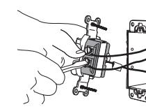
Bornes de tornillo: Afloje los tornillos.
